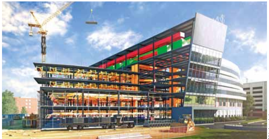
Digitale Bauprodukte rationalisieren die Bauplanung und können per VR- oder AR-Brille präsentiert werden.
