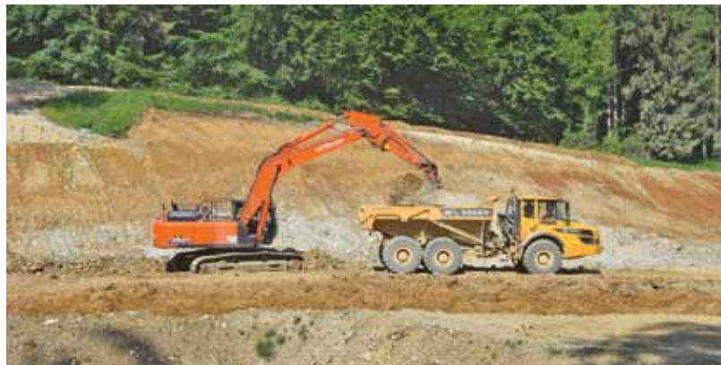
Erdarbeiten auf der Baustelle
