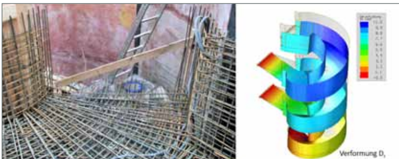
Verlegung der Bewehrung, Verformung Gesamtsystem
