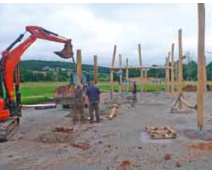
Bauarbeiten beim Kletterpark
