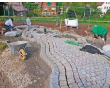
Gestaltungsarbeiten für den Wasser- und Sandspielplatz
